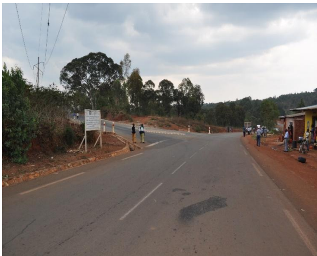
Photo n°7 : Entrée dans la RN15 de la desserte RN12-RN15 permettant le contournement de Zege et Bwoga I
